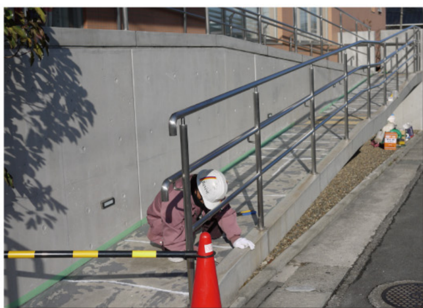
スロープ施工前
